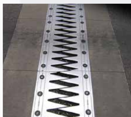
Khe co giãn răng lược – Finger joint
